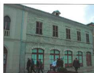
Fasada Aktuale e Objektit
