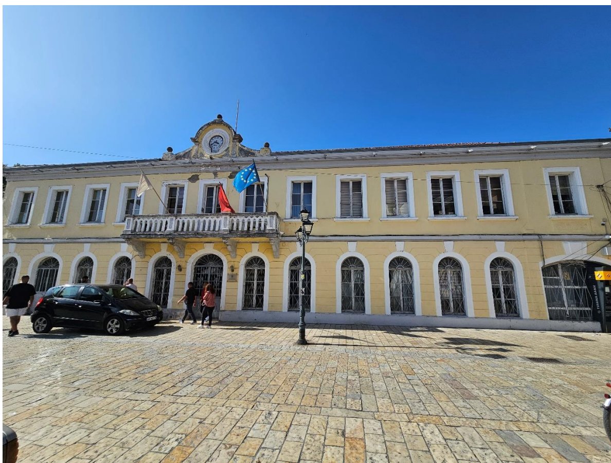
Foto 4. Foto e fasadës kryesore
