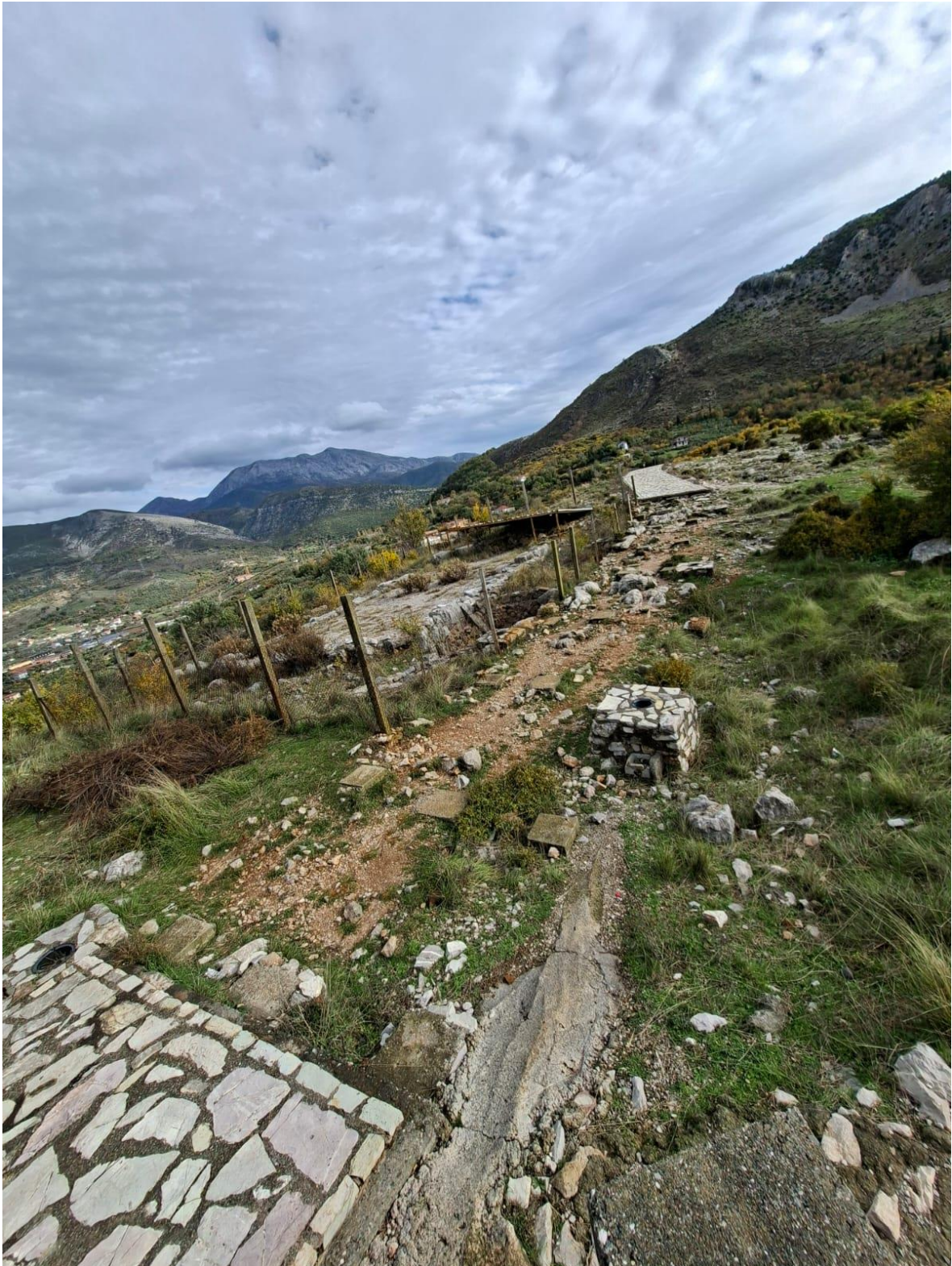
FOTO TË GJENDJES EKZISTUESE (Nëntor 2025)
